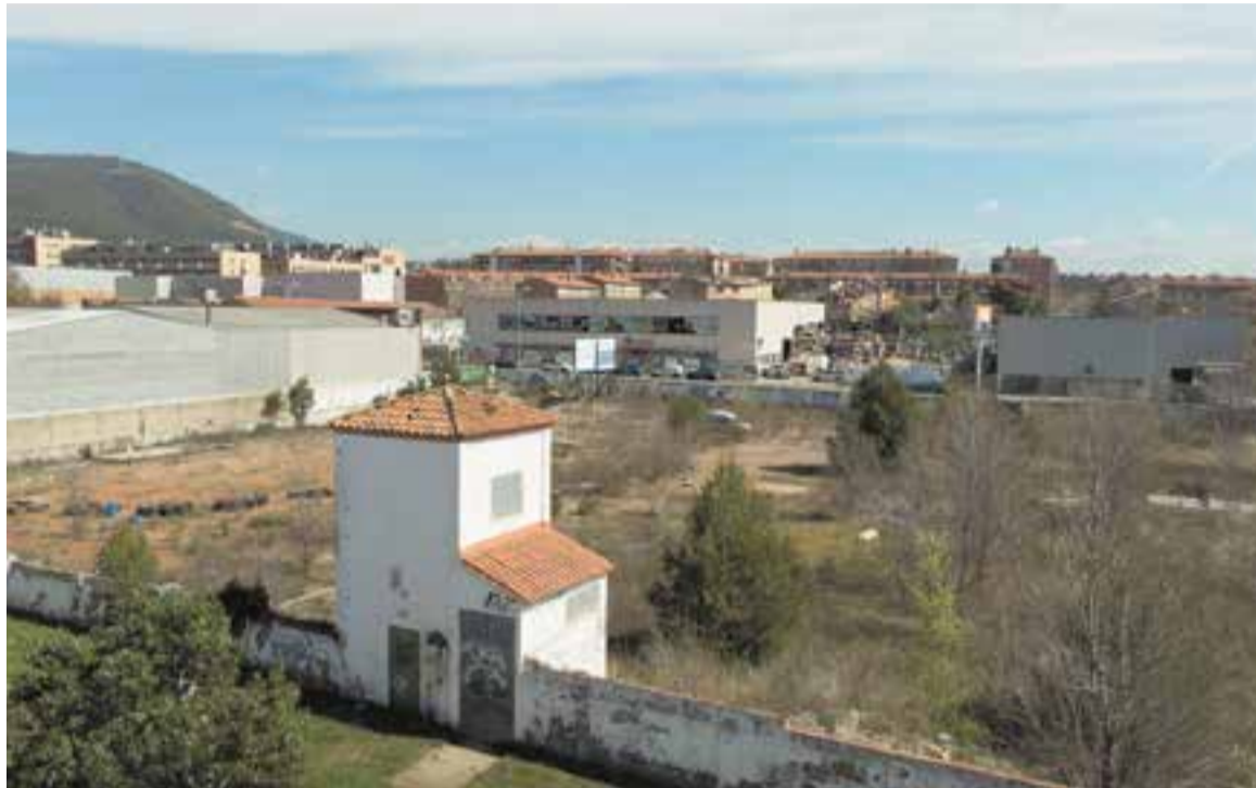
Vista aèria del solar de la Playtex, on s'aixecarà la promoció d'habitatge de lloguer més important de Castellar. || ARXIU
